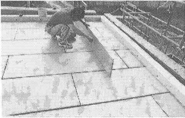
写真-3 乾式二重床下地のレベル調整（実験室 A）
