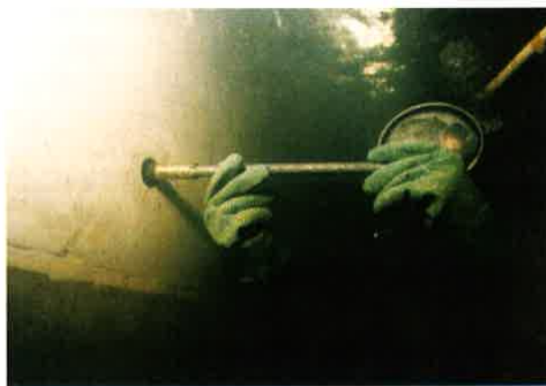
写真-5 拡底式アンカーの取り付け状況(水中)
