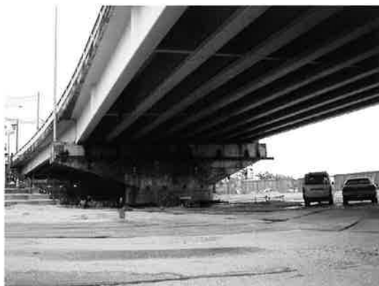
写真-1 耐震補強を行った波の上橋
