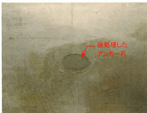
写真-7 拡底式アンカー孔の後処理状況 (水中硬化性エポキシパテ)
