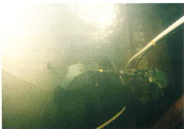
写真-4 拡底式アンカー孔の施工状況(水中)
