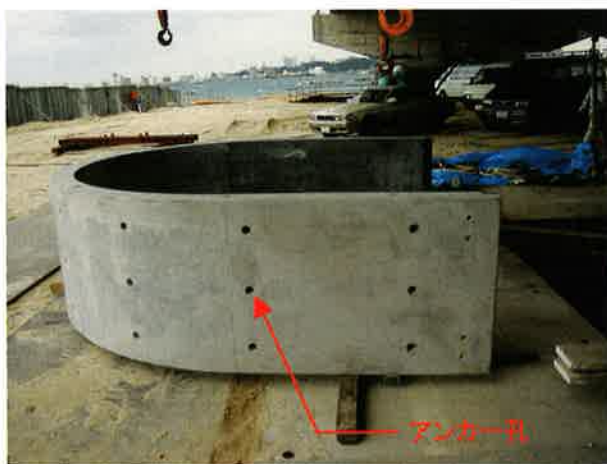
写真-3 プレキャスト型枠に設けられた 拡底式アンカーの孔
