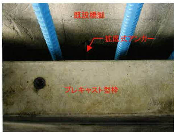
写真-6 拡底式アンカーの設置状況
