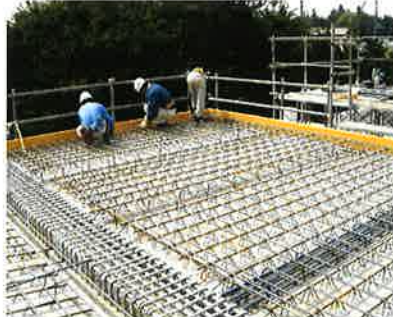
⑤スラブ上端鉄筋組立
