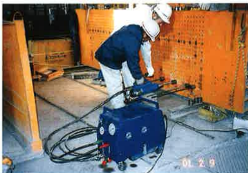
写真-5 プレストレス導入状況
