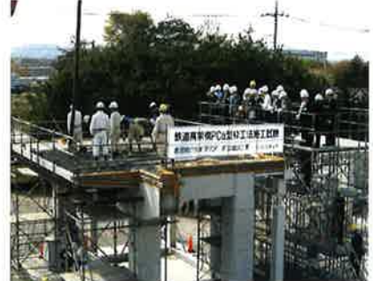
⑥コンクリート打設
