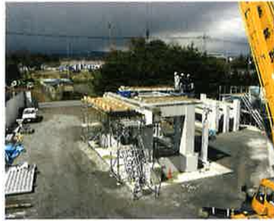
②中間スラブ設置
