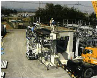
④張出しスラブ設置
