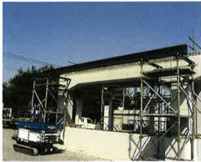
①張出しスラブ支保工組立
