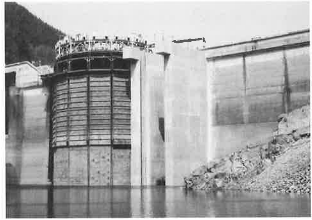
写真-5 取水塔躯体の完成状況
