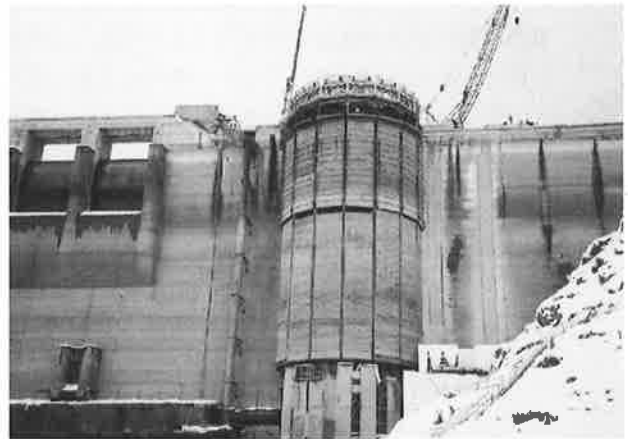
写真-2 朝日ダム上流面側の状況
