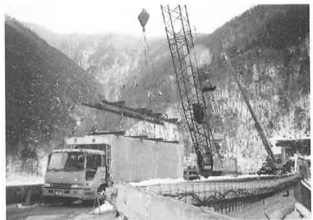
写真-3 SEEDフォーム函体の搬入状況
