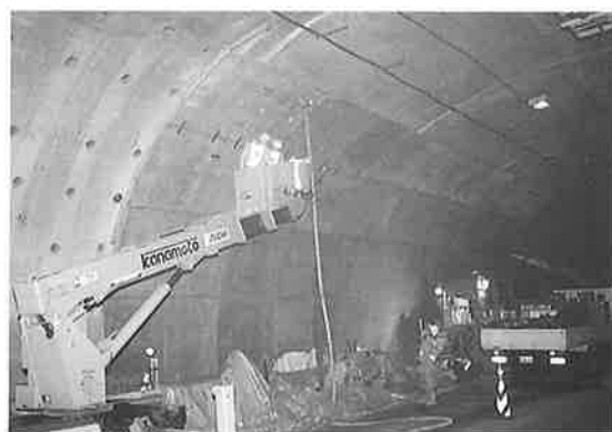
写真-6 無収縮モルタルの充填状況
