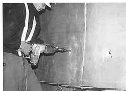
写真-4 ケミカルアンカー打設状況
