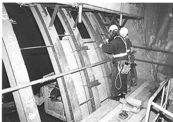
写真-3 背面側での固定状況
