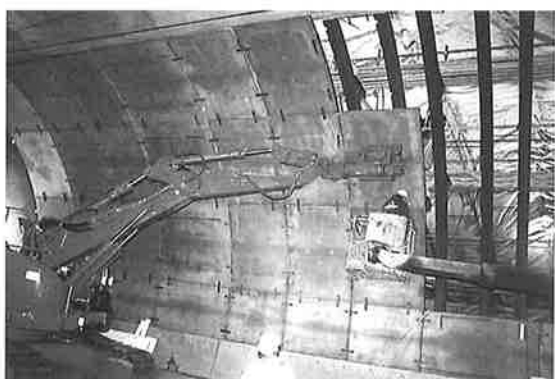
写真-2 SEEDフォームの設置状況(豊浜トンネル側)
