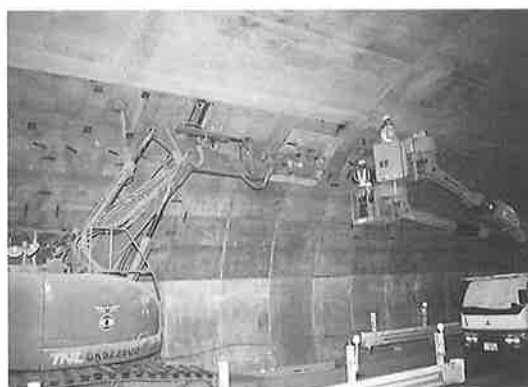
写真-5 打増し部の設置状況(豊浜トンネル側)
