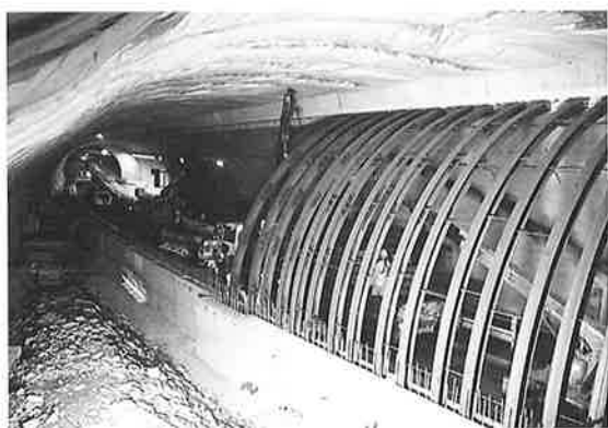
写真-1 支保鋼材設置状況
