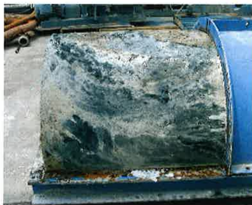
写真-4 脱型状況（ケース3：端部）
