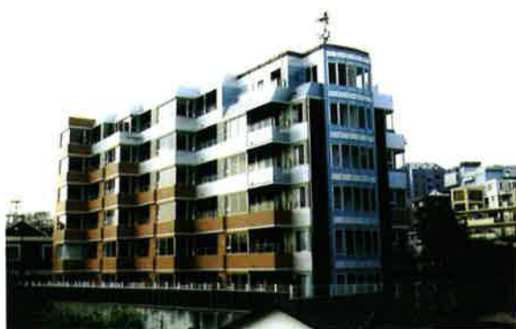
写真-3 建物全景
