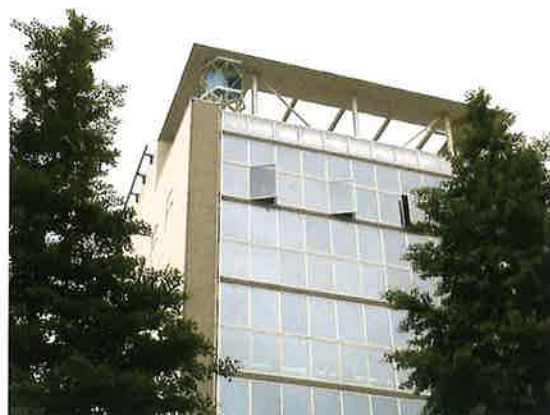
写真-5 風車及び建物正面
