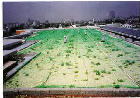
写真 6 春日マンション施工直後
