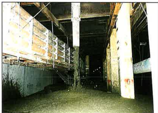
写真-1 流動化処理工法の施工状況
