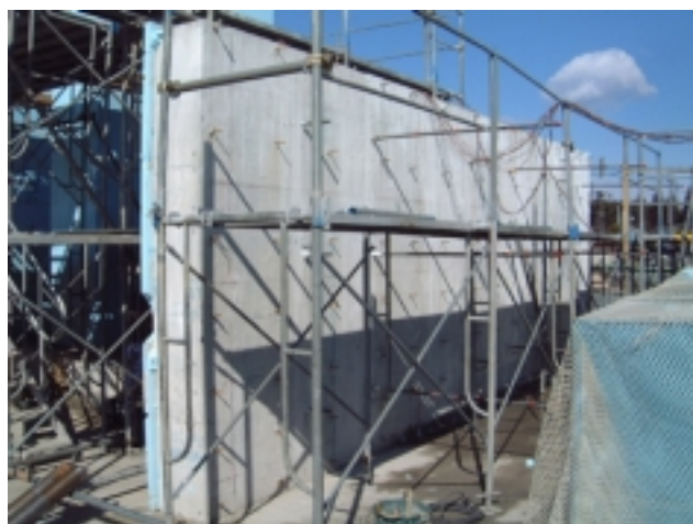
写真—1 構造物の状況 (施工方法 A)
