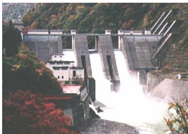
写真-1 完成したの宇奈月ダム
