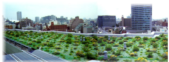
写真-3 屋上緑化システム
