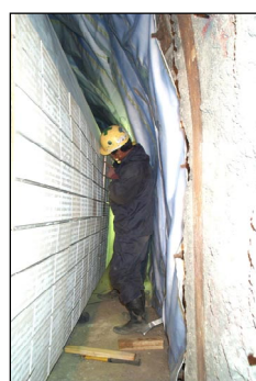
タイルシート設置
