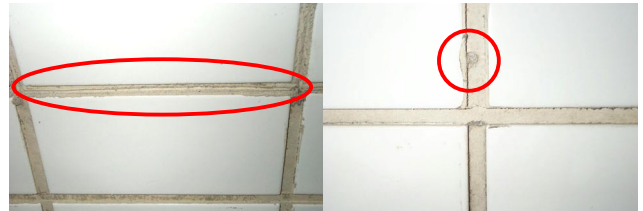
写真-6 目地仕上がり状況(左:番線止め, 右:木ネジ止め)
