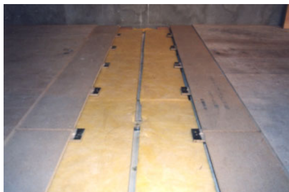
写真-2 試験体の施工状況 (対策B;床下に吸音材を敷き込み)
