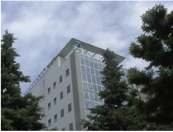
写真-3 青葉ビル（晩翠通りより）
