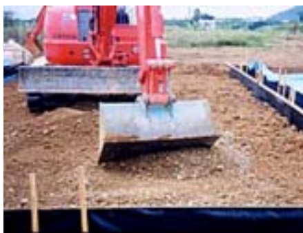
写真 - 2 造粒マルチング施工状況
