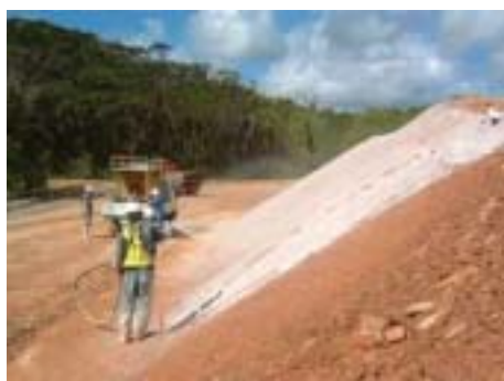
写真 - 6 盛土材仮置き法面への適用状況
