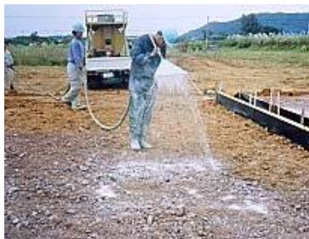
写真 - 3 液状マルチング施工状況
