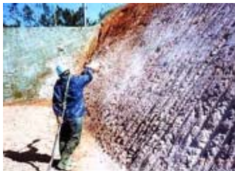
写真 - 5 仮設切土法面への適用状況
