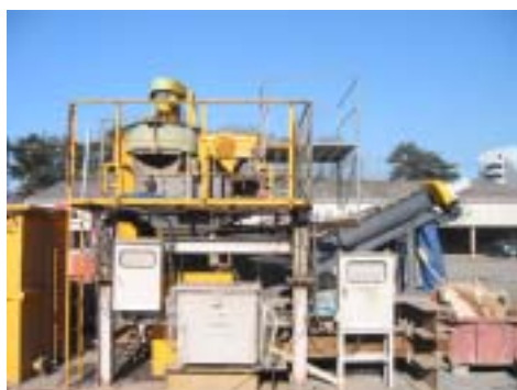
写真- 2 実証実験で使用した土壌洗浄システム全景
