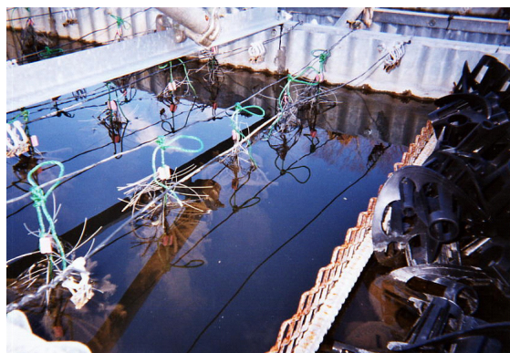
図-9 接触酸化槽に設置されたカーボン繊維
