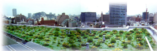
写真-1 集合住宅屋上緑化(図-1 A 方向より望む)
