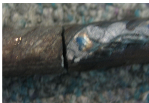
写真-10 ラチス筋を取り外した状況
