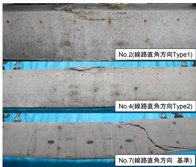
写真-4 線路直角方向試験体破壊状況
