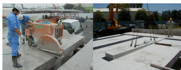
写真-3 試験体切出し状況（左）搬出状況（右）
