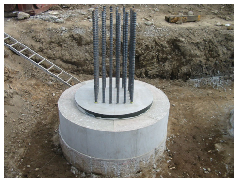
写真-1 杭頭接合部の出来型（例）
