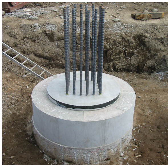
写真一 杭頭接合部出来型
