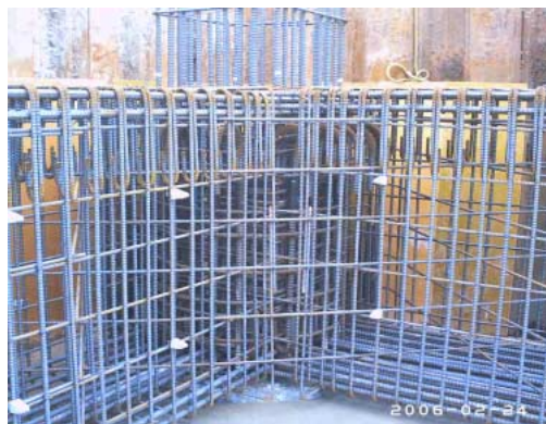
写真 1 鉄道 RC ラーメン高架橋部材接合部の例
