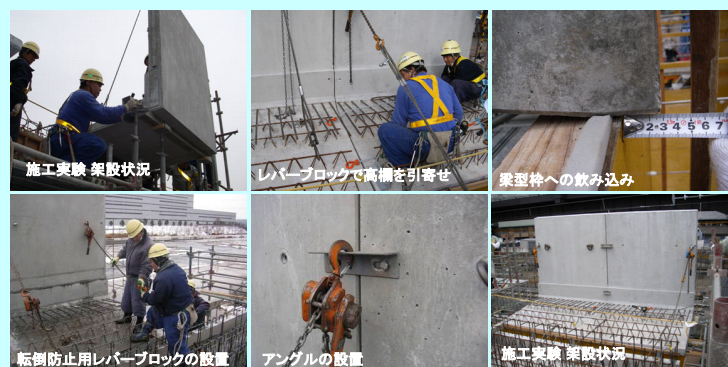
写真-12 施工実験による PREX 高欄の架設
