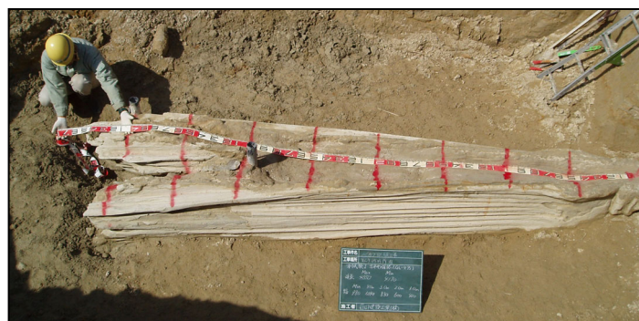
図-2 改良径確認状況(半径 R=4.5m)
