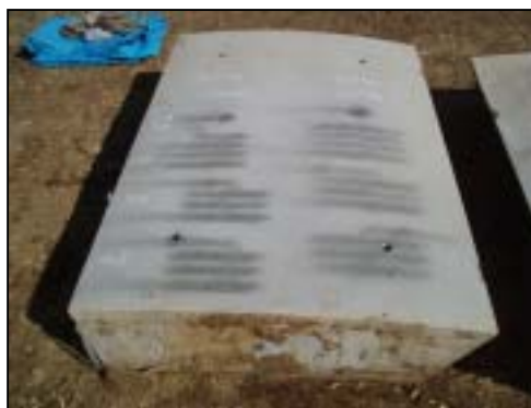
図-21 セグメント損傷状況 (ケース 1～8)
