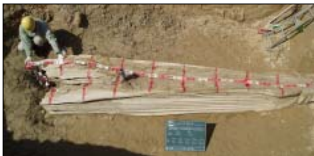
図-19 本試験 1 改良径確認
