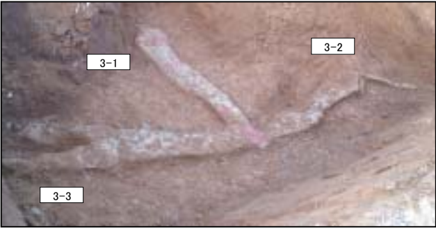
図-17 ケース 2-1～2-3 改良径確認
