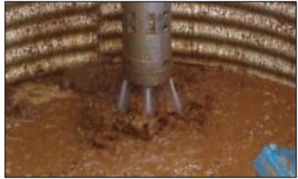
図-7 ジェット削孔状況(先端部)
