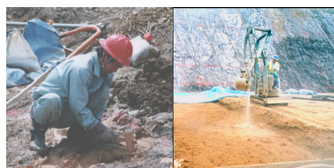
コンタクトクレイの施工状況 左：従来施工 右：吹き付け工法
