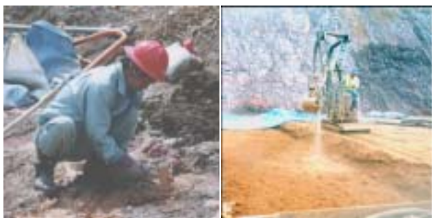
(a)コンタクトクレイの貼付 (b)コンタクトクレイの吹付け 写真-1 コンタクトクレイの施工
