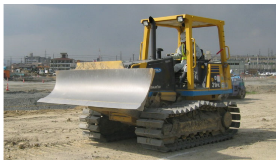
写真-1 ブルドーザー移動加振状況
