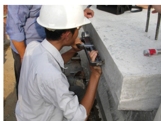
写真-11 ひずみ計測状況
