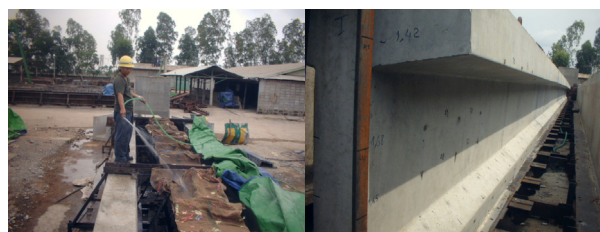
写真-10 左：養生状況，右：PC 桁の完成状況
