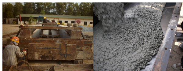
写真-9 左：製作ヤード，右：SCC 打設状況
