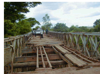
写真-2 鋼製の橋梁 4)
