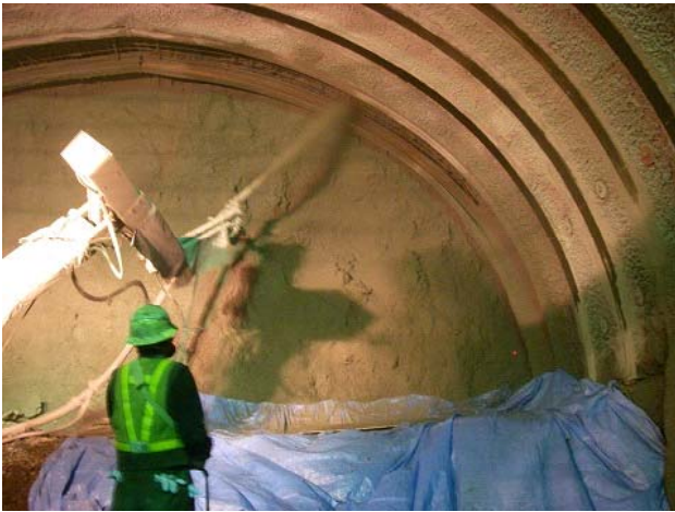
写真-2 吹付け試験状況（リバウンド試験）
