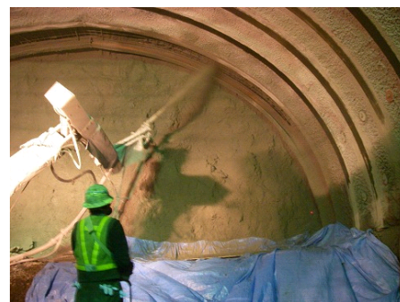
写真-1 吹付け試験状況
