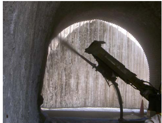
写真-1 吹付け試験状況（模擬トンネル）
