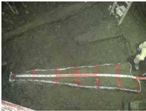
図-35 壁状改良体
