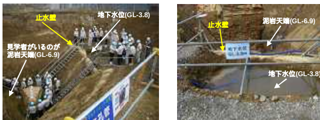
図-49 地下水位以下での改良体見学状況
