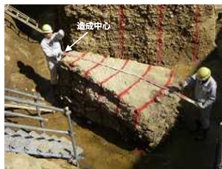
図-47 試験施工改良体
