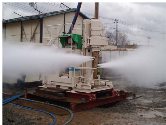
図-2 マルチジェット工法噴射状況
