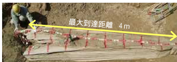
図-8 大口径改良体(改良直径 \phi 8.0\text{m} )
