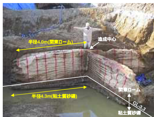
図-7 大口径改良体(改良直径 \phi 8.0\text{m} )
