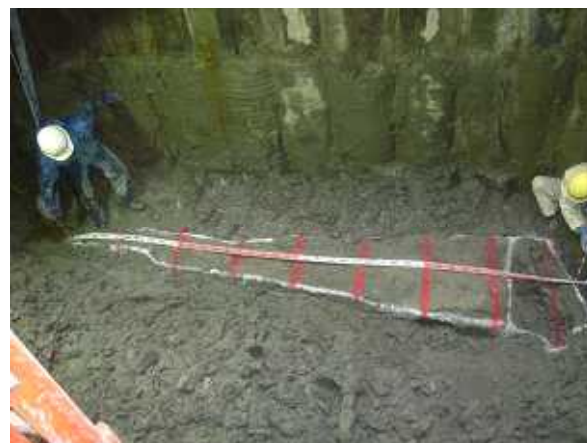
図-34 掘削による出来形確認例(粘性土)
