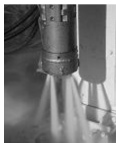
図-23 ジェット削孔状況
