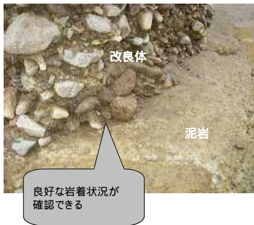
図-48 改良体と泥岩との岩着状況
