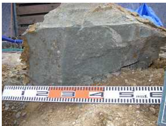
図-44 改良体断面状況
