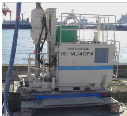
図-21 ボーリングマシン
