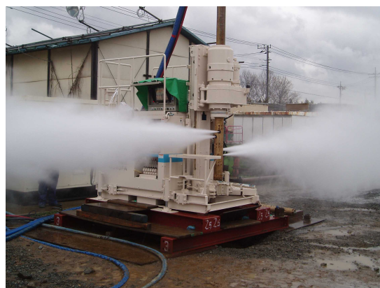
図-22 両側噴射状況
