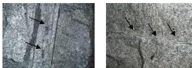
(a) 高角度亀裂
