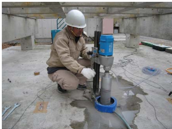
(d) コアドリルによる加振(コア抜き)
