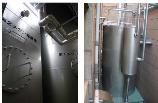
写真-9 メタン発酵槽（左：1 階部、右：天板部）
