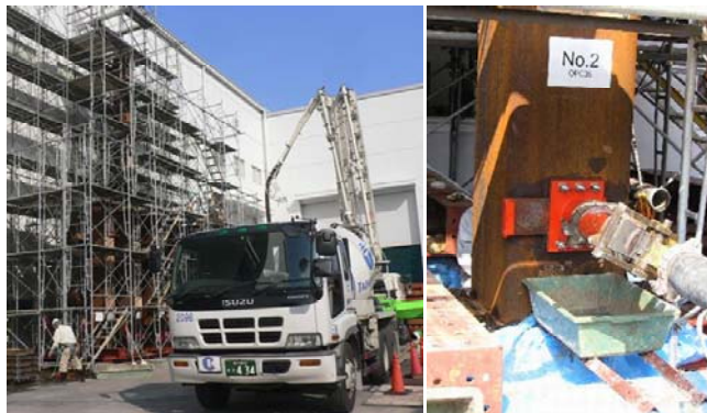
写真 実大施工実験状況
