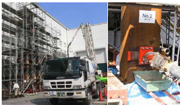
写真-1 実大施工実験状況
