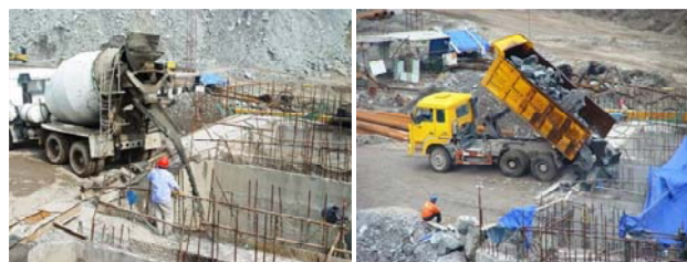
SCCの充てん 堆石の投入 図-27 堆石コンクリート施工状況
