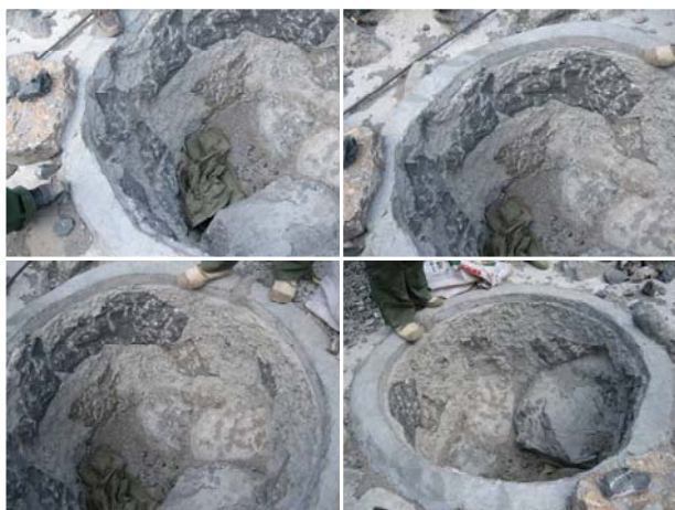
図-19 現場密度試験実施状況
