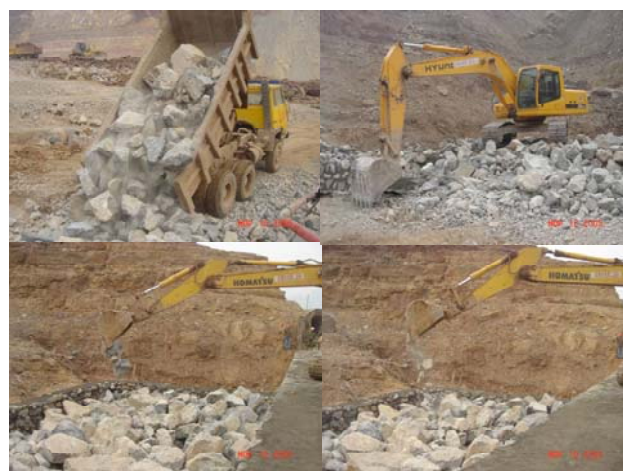
図-17 ダンプトラック及びバックホウによる堆石の施工
