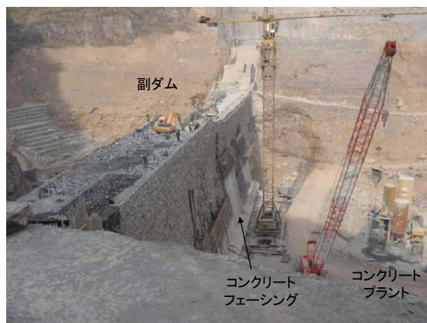
図-21 副ダムの施工状況
