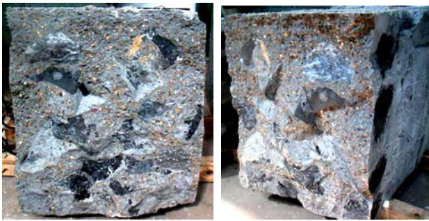
a) 左側破断面 b) 右側破断面 図-9 曲げ試験後の試験 1 試験体の破断面
