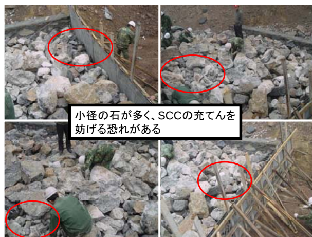
図-28 堆石施工状況（粒径 10cm 以下の石が多い）
