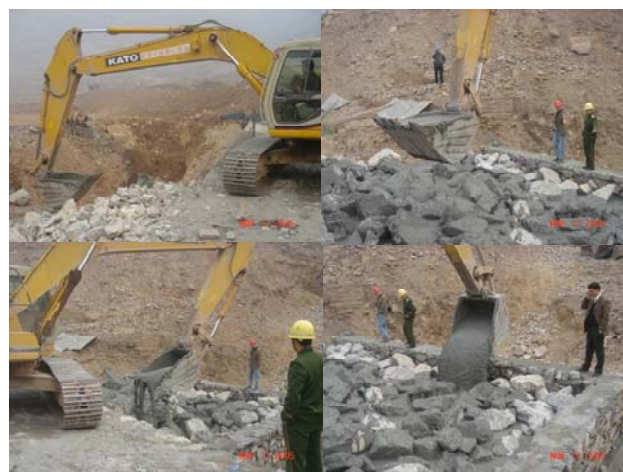
図-18 バックホウによるSCCの打設
