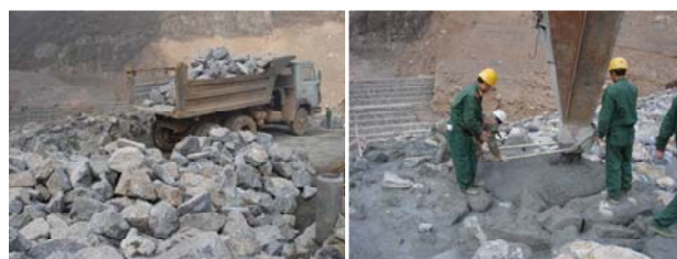
ダンプトラックによる堆石の投入 クレーンホッパーを用いた SCC 打設
