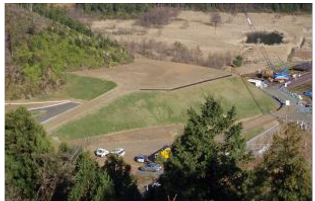
写真-1 解析対象とした载荷盛土現場
