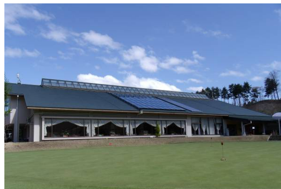
写真-1 建物全観（改修後、西側）
