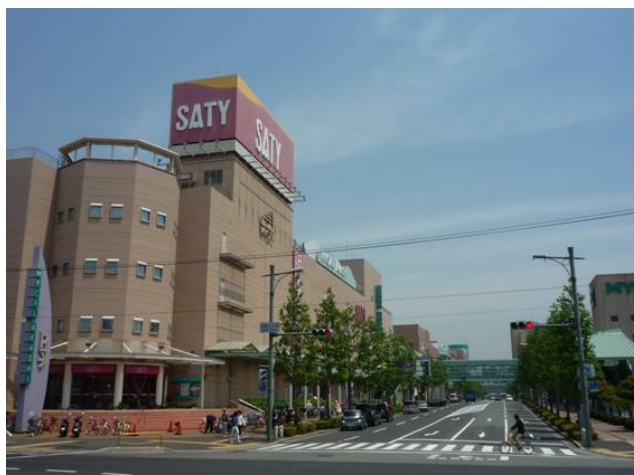
写真-1 マイカル明石店舗外観
