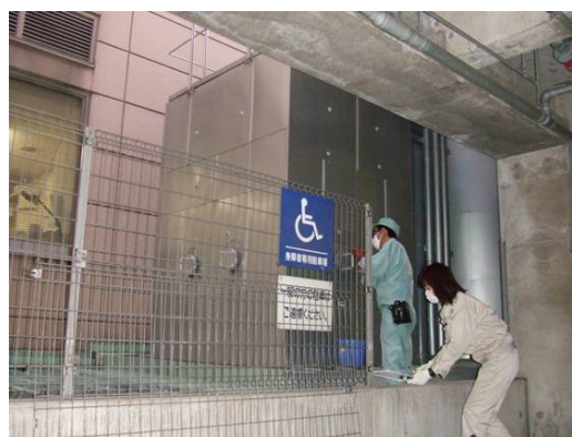
写真-4 DHS スポンジ担体サンプリング状況
