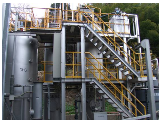
写真-7 調査対象設備
