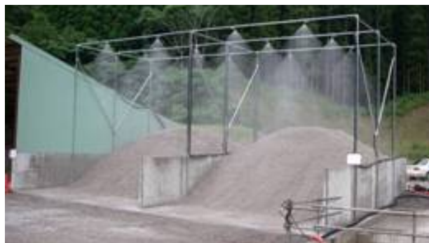
写真-6 骨材散水設備
