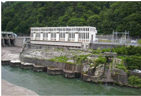
写真-1 既設発電所外観(改修工事着工時)
