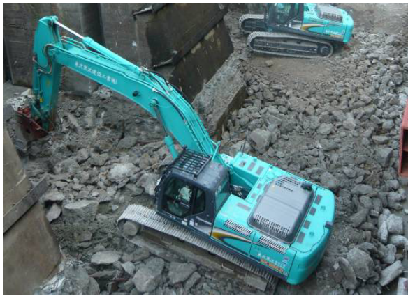
写真-2 既設構造物撤去状況
