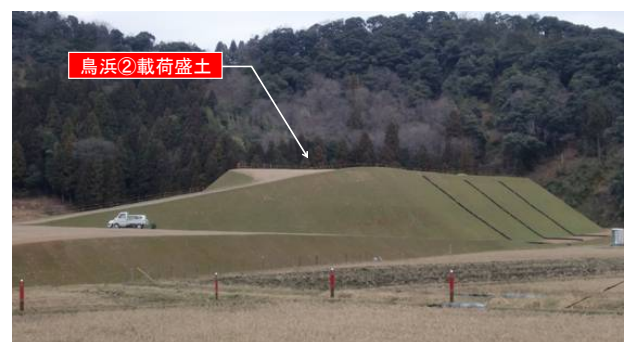
写真-4 鳥浜②载荷盛土の全景
