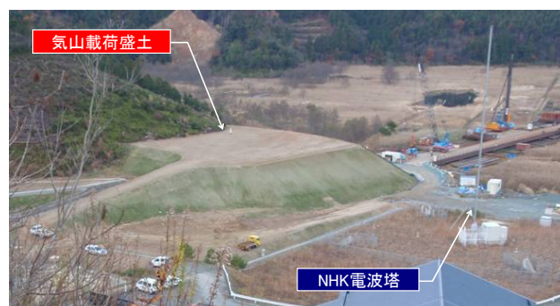
写真-6 気山载荷盛土の全景
