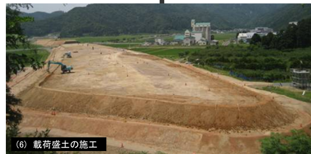
写真-2 鳥浜②载荷盛土における真空圧密工法の施工状況定点写真
