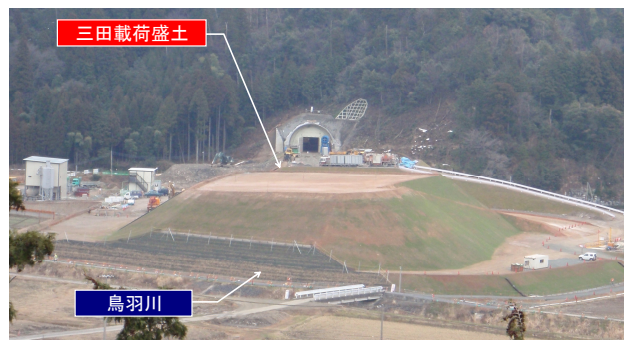
写真-3 三田载荷盛土の全景
