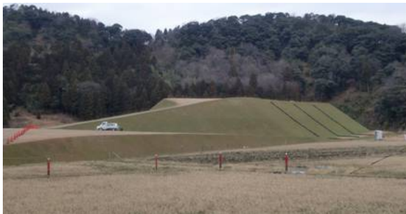
図-1 真空圧密工法を適用した載荷盛土
