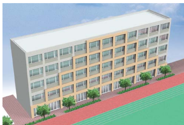
図-1 MaSTER FRAME 構法による補強例外観
