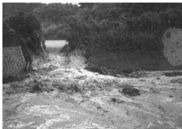
写真-1.1 豪雨によるため池の決壊事例 2)
