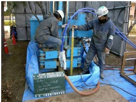
写真-3 Type1 U チューブ挿入状況
