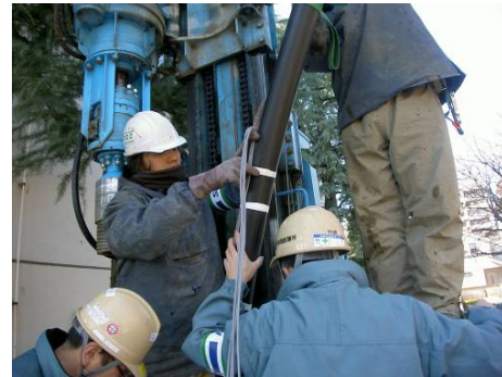
写真-5 二重管外管挿入状況
