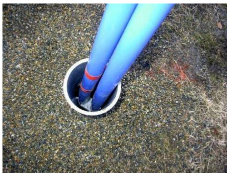
写真-4 Type2 U チューブ挿入状況
