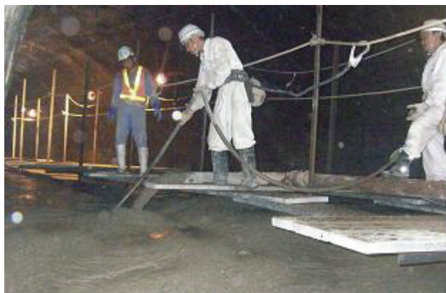
写真-1 充てん用再生コンクリートの打設状況
