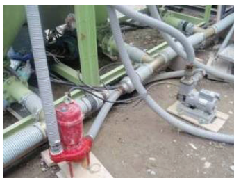
写真-12 汚泥引抜きポンプ設置状況
