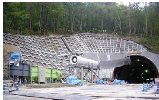
写真-10 濁水処理設備設置状況概況
