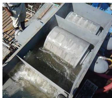
写真-5 分離槽への金網設置状況
