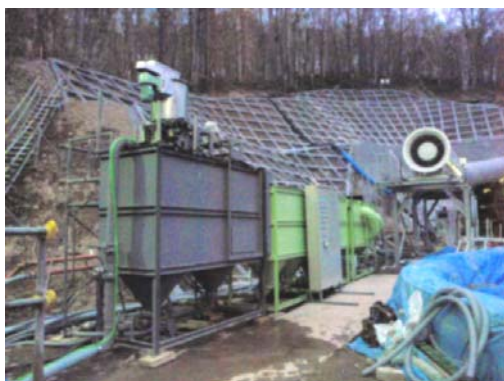
写真-1 トンネル現場での実証実験状況
