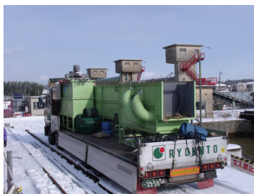
写真-14 濁水処理設備の搬出状況
