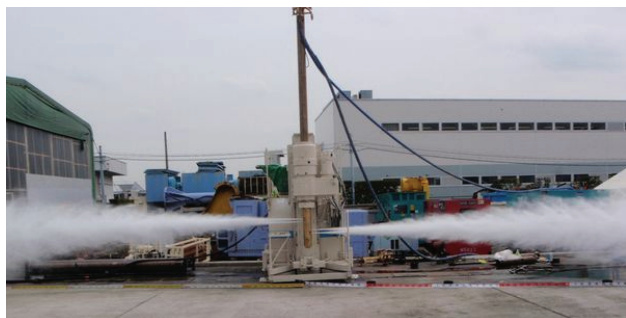
図-1 マルチジェット工法
