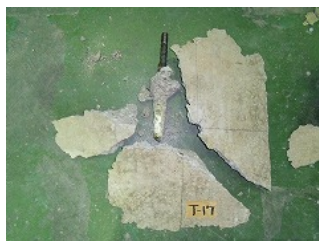
T-17 破壊状況
