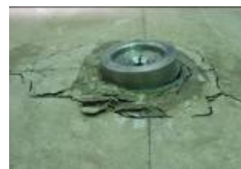
写真-2 せん断実験破壊状況
