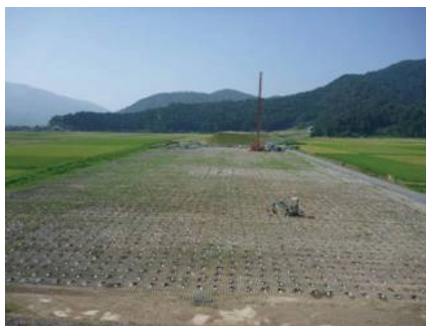
写真-5 向笠地区における PBD 施工状況
