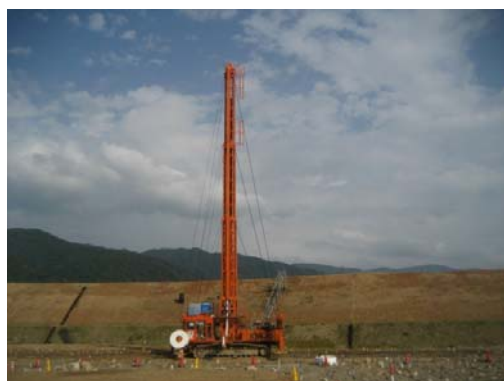
写真-1 PBD の施工状況
