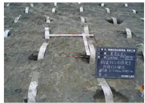
写真-4 PBD 打設事例 (1.0m×1.0m)
