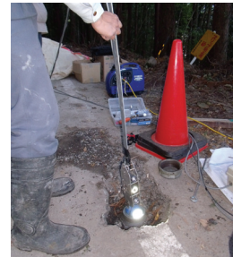
写真-8 CCD カメラ挿入状況
