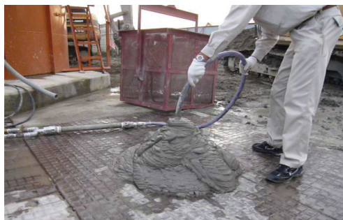
写真-4 打設状況
