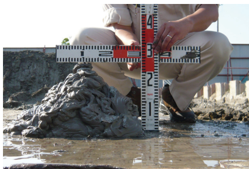
写真-5 打設形状
