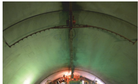
写真-4 移動式散水養生システム
