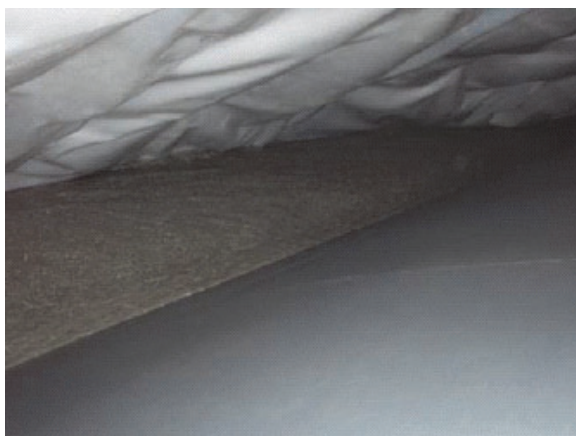
写真-3 中流動コンクリートの充填状況
