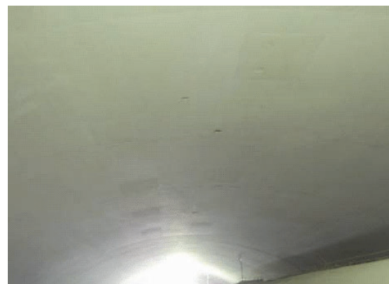
写真-5 覆工天端部の仕上がり状態
