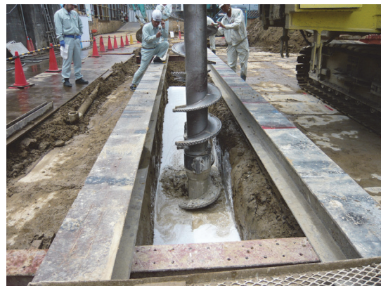
写真-3 施工状況
